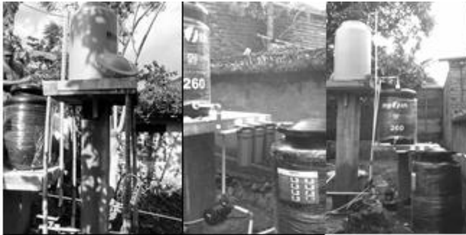
Gambar 2. Pembangunan unit pengolahan air siap minum
