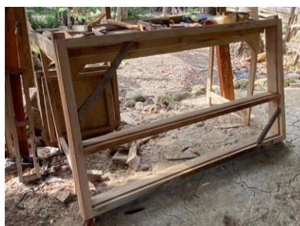
Gambar 12. Kusen (Sumber: Dokumentasi pribadi)
