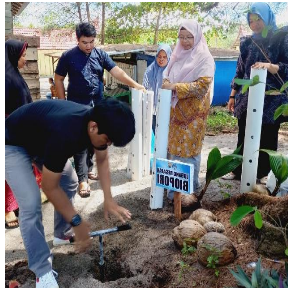
Gambar 2. Proses pembuatan lubang resapan biopori oleh masyarakat sebagai penerapan teknologi pengelolaan sampah organik dan konservasi air di kawasan ekowisata pesisir.
