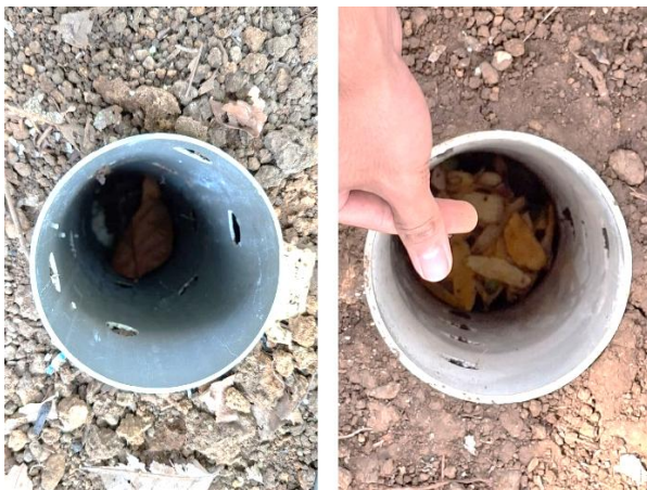
Gambar 3. Kondisi lubang resapan biopori pada saat pemasangan (Hari ke-1) dan hasil monitoring (Hari ke-7).
