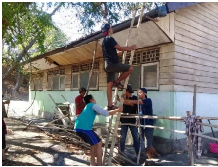
Gambar 3. Proses pemasangan talang air di atap sekolah
