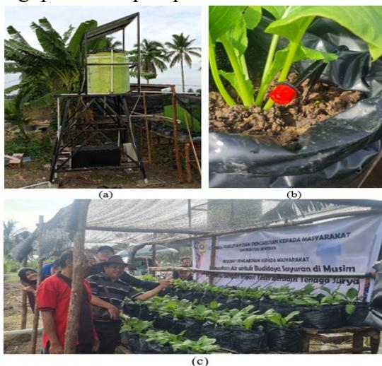
**Gambar 4.** Hasil Pemasangan (a) sistem irigasi tetes (b) nozzle tetes untuk tanaman (c) tanaman sayuran yang telah tumbuh
