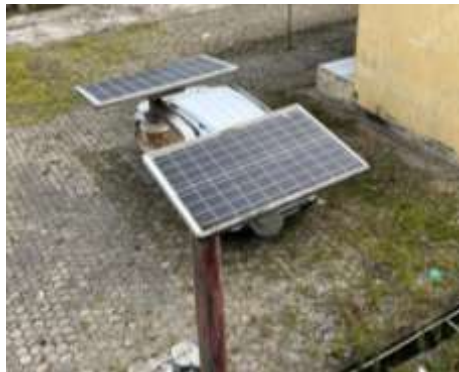
Gambar 8. Tiang Lampu Jalan
