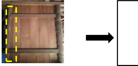
Gambar 8. Bentuk persegi panjang pada Dinding rumah adat Soka Bu'ahan
